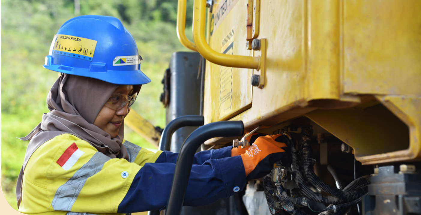
Syafitri Khairunisa (Kontraktor PTAR) hatia pareso sistem listrik excavator.
