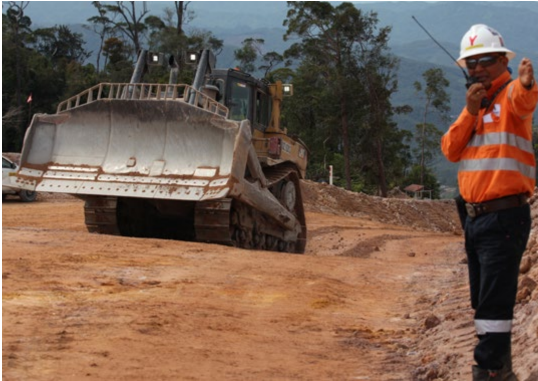
Yonatan Kalua, TSF and Civil Construction Manager sedang mengarahkan operator bulldozer di Pit Ramba Joring agar tidak bentrok dengan ekskavator.
