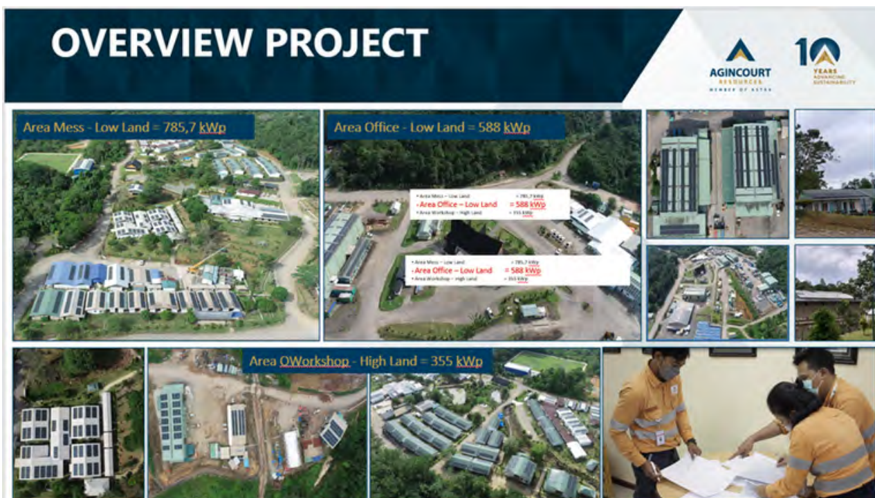
Gambar 3. Overview Program Pemasangan Solar PV
