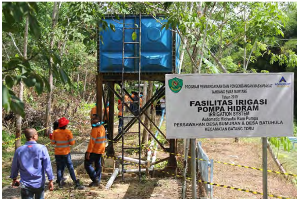
Gambar 7. Fasilitas Irigasi Pompa Hidram di Desa Batuhula
